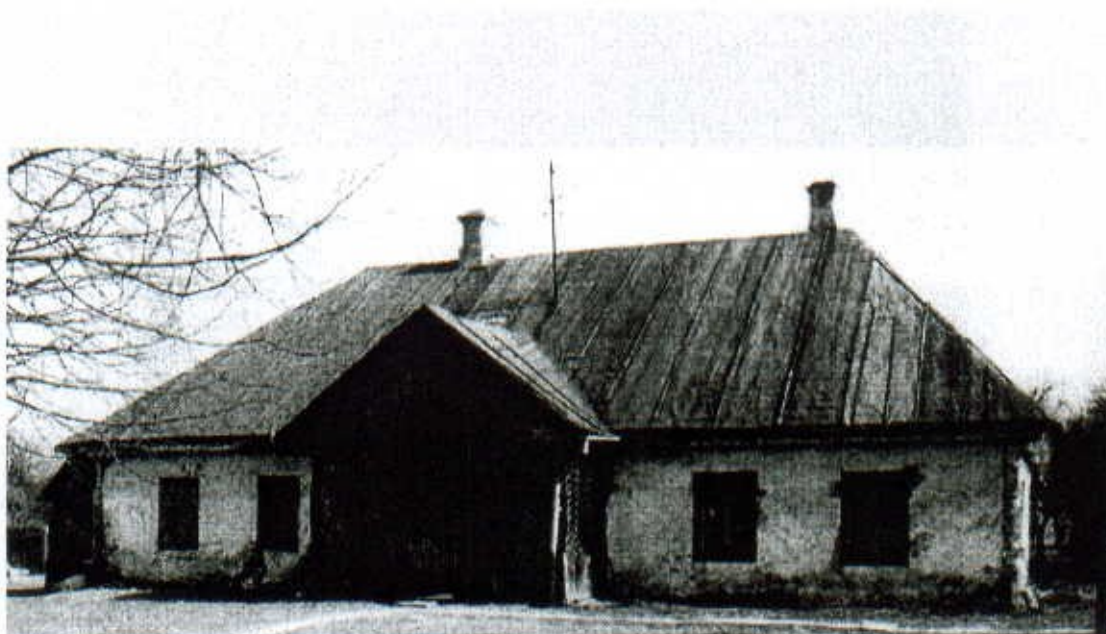
Plebania z Goźlic - elewacja frontowa. Widok przed przeniesieniem (zdjęcie archiwalne)
