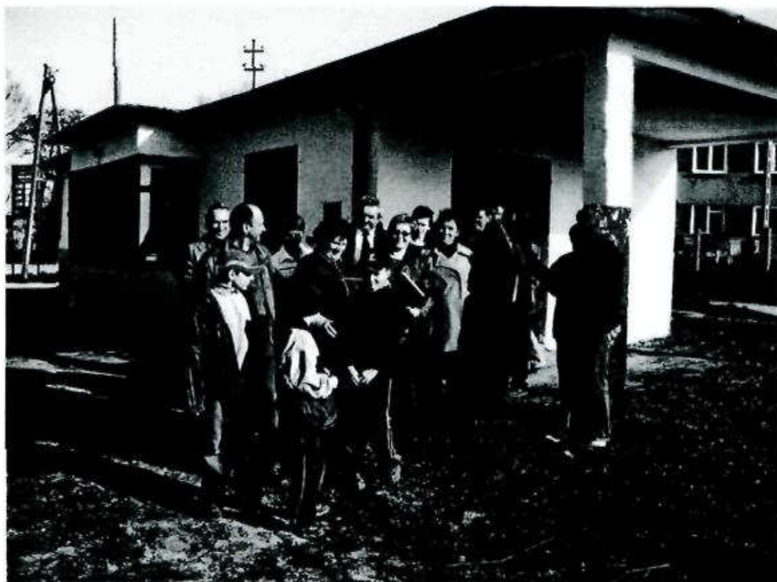
Fot. Piotr Gajewski. Mieszkańcy Górek wraz z władzami Gminnymi na tle remontowanej świetlicy
