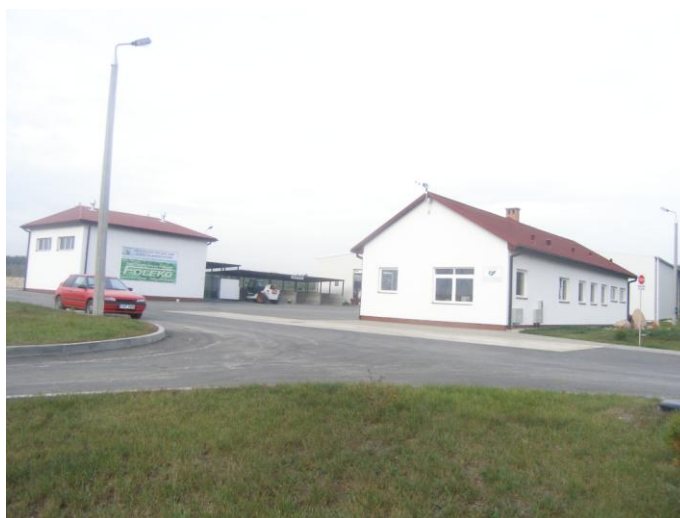
Budynek administracyjno-socjalny Fot: ezgdk.pl/pic/zaklad/fot_19.jpg
