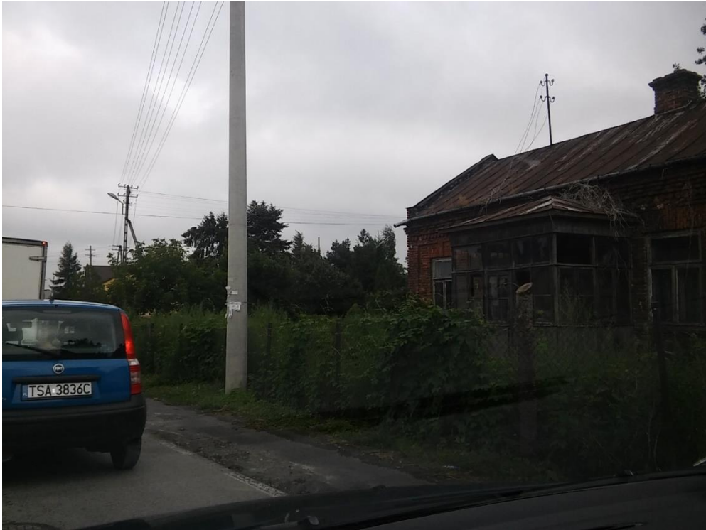
Zniszczone budynki mieszkalne w centrum Klimontowa
