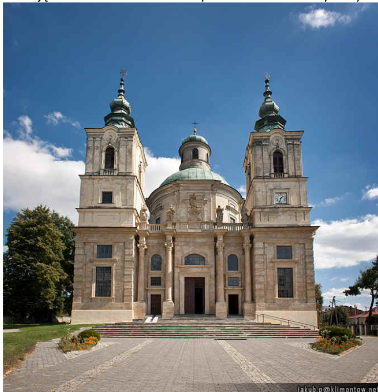
Zdjęcie nr 4 Kościół św. Józefa po odnowieniu fasady budy
