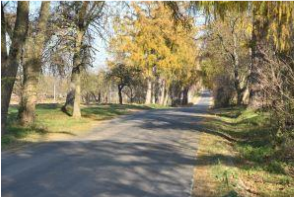
Droga Nowa Wieś – Julianów po rozbudowie
