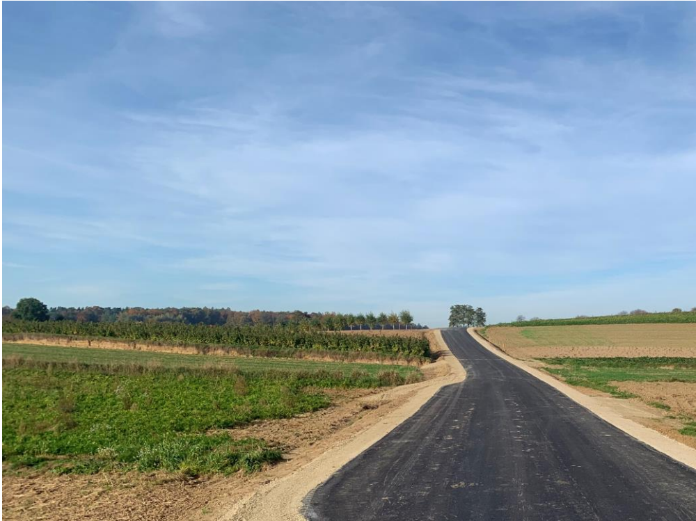
Droga Płaczkowice – Beradz po rozbudowie
