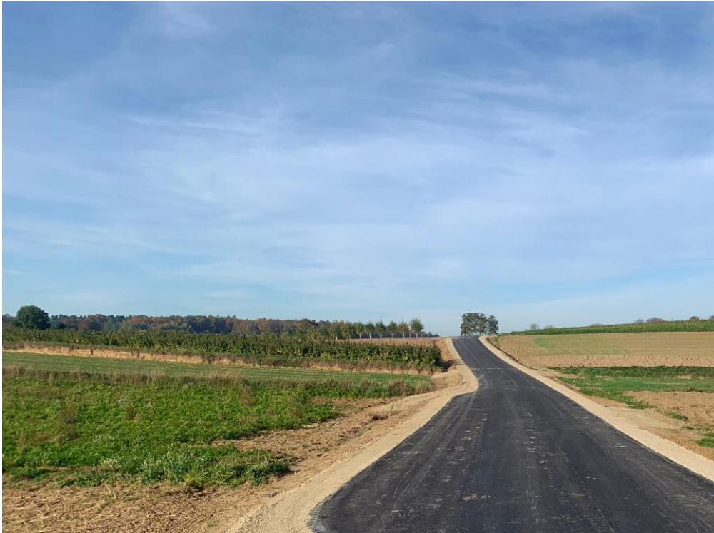
Droga Płaczkowice – Beradz po rozbudowie
