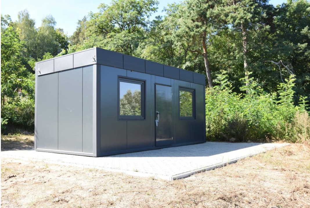
Świetlica kontenerowa w Rybnicy
