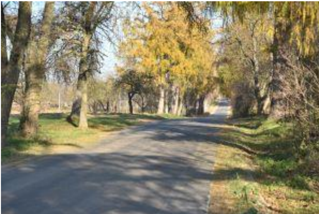
Droga Nowa Wieś – Julianów po rozbudowie
