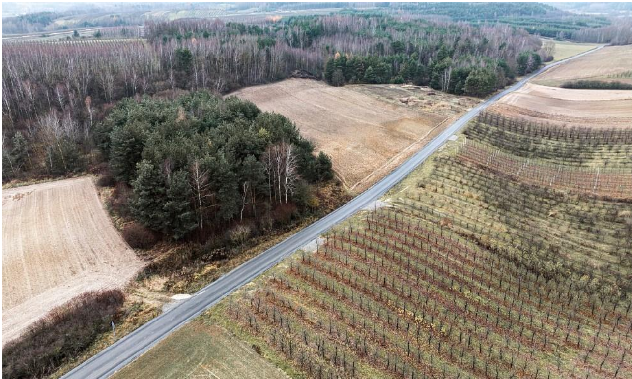
Zdjęcie 4: Rozbudowa drogi gminnej nr 331018T Nawodzice-Wólka Gieraszkowska
