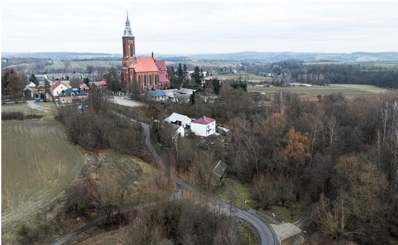
Zdjęcie 7: Rozbudowa drogi gminnej w Olbierzowicach
